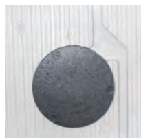
Zustand im Rohbau
