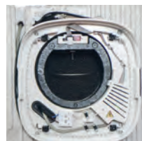
Lüftung im Kasten verbaut
