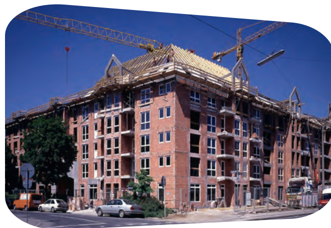
Bild 1 und 2: Homogenes Ziegelmauerwerk
