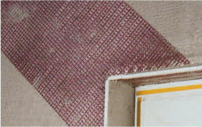
Bild 7: Armierungspfeil an Öffnungsecken
