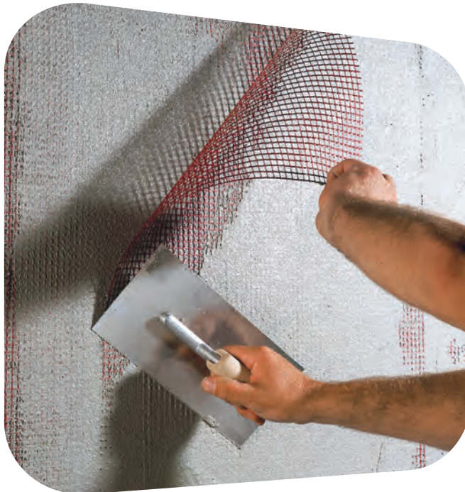
Bild 8: Armierungsputz mit Gewebeeinlage
