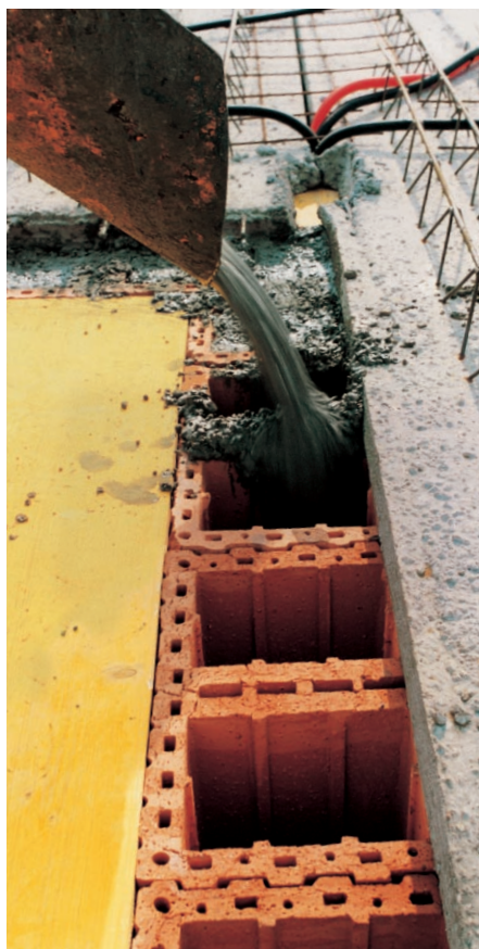
Bild 12 Schallschutz-Füllziegel.
