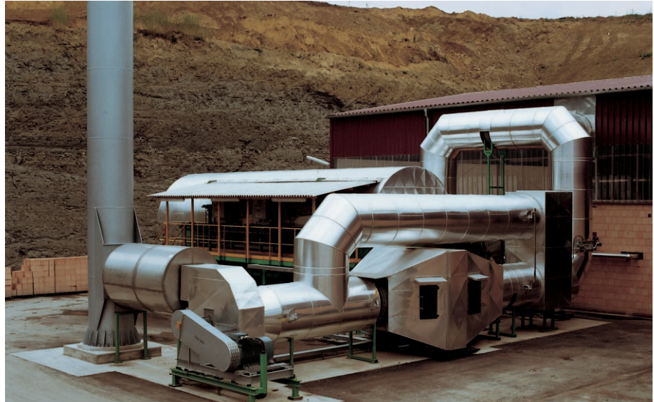
Bild 32 Moderne Ziegelwerke mit Rauchgasreinigungsanlagen erfüllen alle Anforderungen der Technischen Anleitung (TA) Luft [24].
