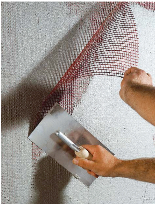
Vollflächiges Einbetten des Armierungsgewebes in einen Armierungsmörtel
