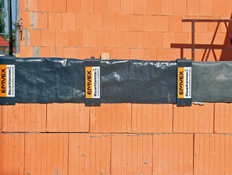
Mauerwerk im Bauzustand: Fachgerecht abgedeckte Mauerkronen
